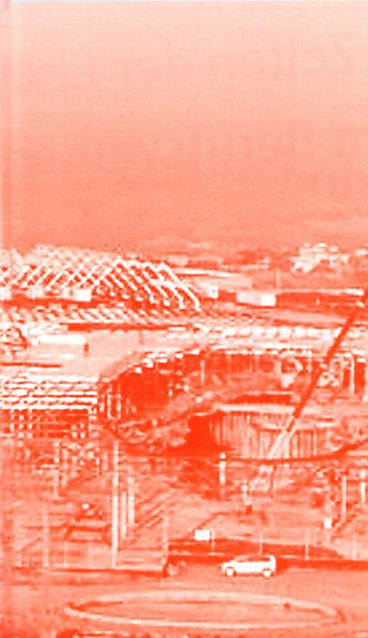
rahmen im Abstand von 16,00 m. Die Auskragung als Fachwerkkonstruktion in Stahl mit Rückhängung in die Stahlbetonrahmen.
